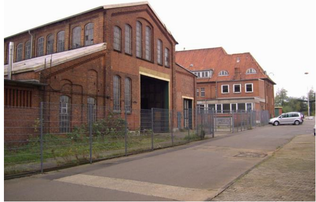
Derzeitige Situation am Ende der „Alten Ladenstrasse“ [B-17]
