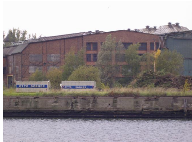
Gebäudeteil mit den wichtigsten Werkstätten [B13]
