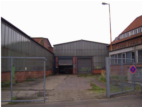
Eingangssituation mit Eingangshalle [B-12]
