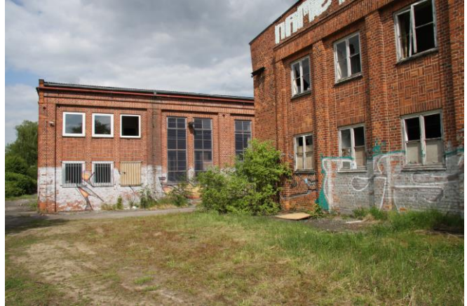
Links der hintere Bereich der Halle 2 und rechts der von Halle 3 [B-31]
